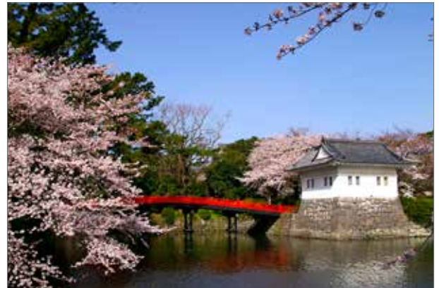
小田原城跡「隅櫓と隅櫓橋」（平成16年3月）
