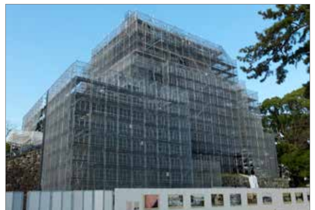
天守の改修工事（平成27年7月～翌年4月）
